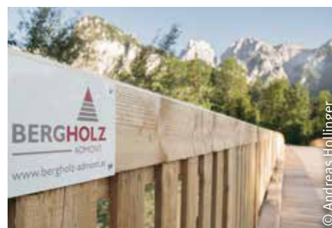
Die neu errichtete Lauferbauerbrücke aus Lärchenholz
