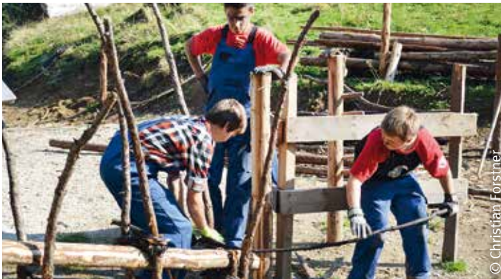
Bau eines Bänderzaunes
